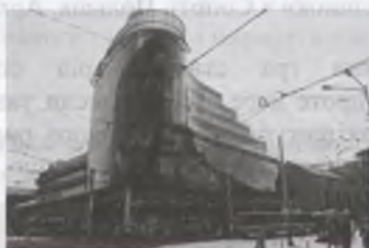
Рис.2. Будівля торгово-офісного центру «Золотий Ангел» в Празі. Арх. Жан Нувель
