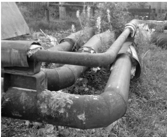
Рис.2. Состояние тепловой изоляции: а) паропровода; б) теплотрассы
