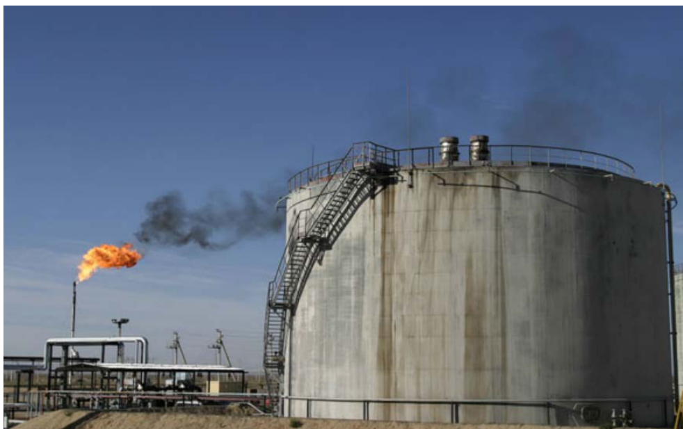
Рис. 4.1. Стан покриття резервуара вертикального сталевго 3000 м 3 нафтового
