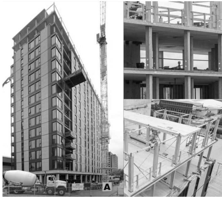
Рис. 4. Багатоповерховий будинок Brock Commons Phase (Британська Колумбія) [14]
