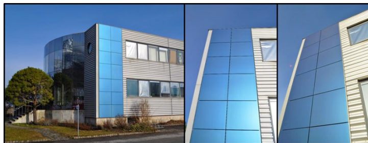
Рис. 5.8. Зовнішній вигляд енергоефективної будівлі з фотоелектричних панелей
