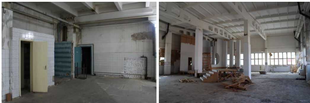
Рис. 4.1.3. Фото інтер'єрів першого та другого рівня вихідної будівлі [23]
