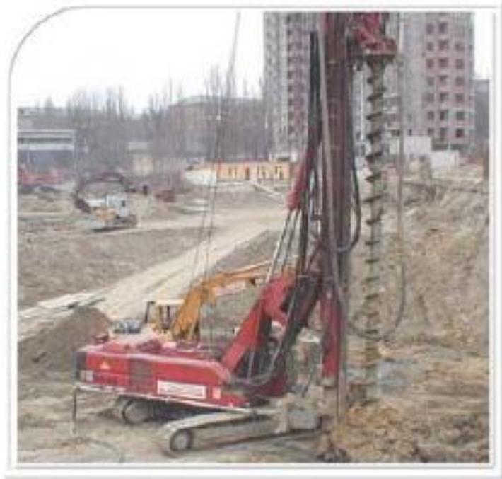
Рис.4.1. Влаштування буроін'єкційних паль
