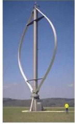
а) з ротором Савоніуса; б) з ротором Масгрува; в) з ротором Дар'є; Рисунок. 3.3. - ВЕУ з вертикальною віссю обертання
