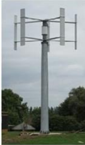
а) з ротором Савоніуса; б) з ротором Масгрува; в) з ротором Дар'є; Рисунок. 3.3. - ВЕУ з вертикальною віссю обертання
