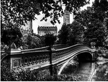
Рис. 24. Міст через озеро в Центральному парку, Нью-Йорк
