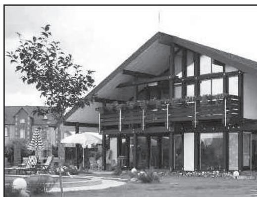
Рисунок 1. Здание, оборудованное системой солнечного теплоснабжения
