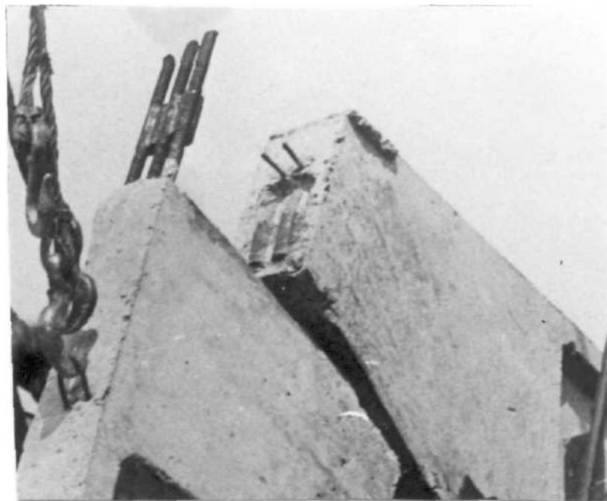
Рис. 3.37. Безварне з'єднання ригеля зі стійкою піврами /завод ЗБВ к. Вінницького Облміжколгоспбуду/
