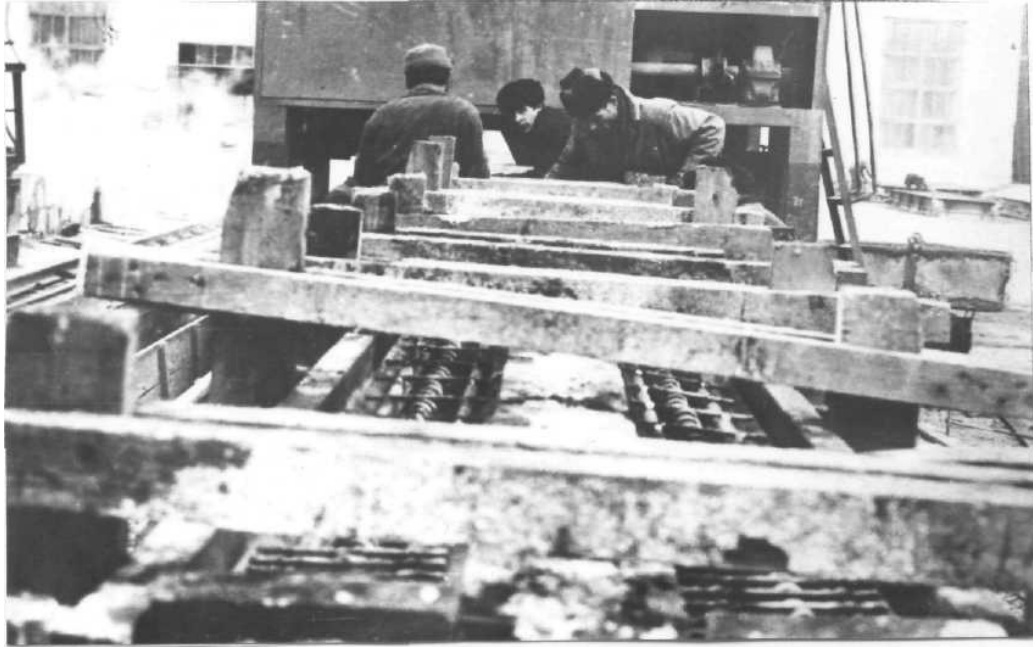
Рис. 3.43. Бетонування ригелів піврам на Рокитнянському заводі ЗБВ к. Київського Облміжколгоспбуду
