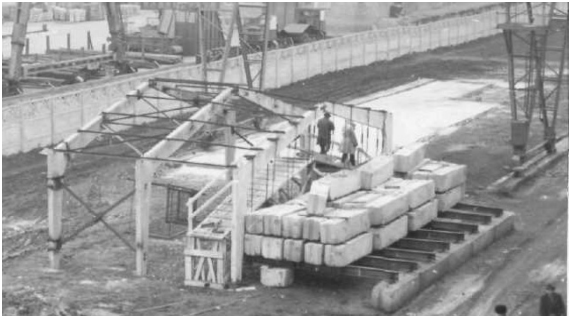
Рис. 3.32. Загальний вид випробування рами прольотом 12 м /завод ЗБВ к. Черкаського Облімжколгоспбуду/
