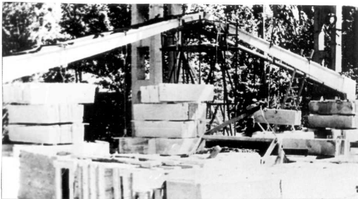
Рис. 3.25. Випробування рами завантаженням штучними вантажами
