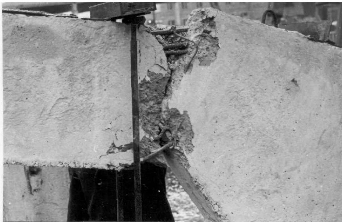
Рис. 3.30. Вузол спрження ригеля зі стійкою суцільної піврами після випробувань
