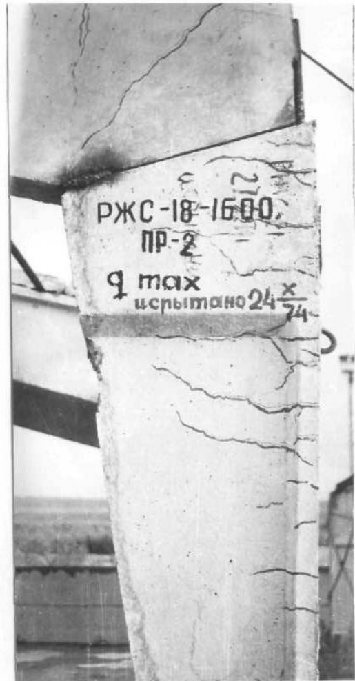
Рис.3.22. Стійка рами РЖС-18-1600 після випробувань /завод ЗБК к. комбінату Сільбудіндустрія Кримського Облміжколгоспбуду/
