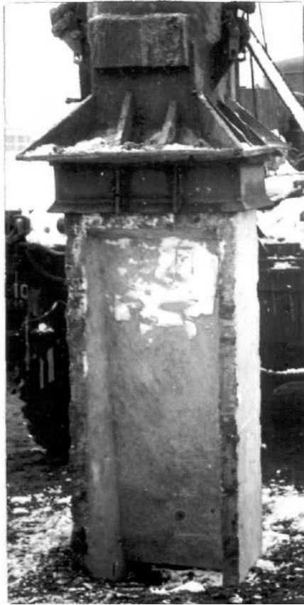
Рис.6.47. Паля з вертикальних елементів, об'єднаних діафрагмами СВД, в процесі забивки
