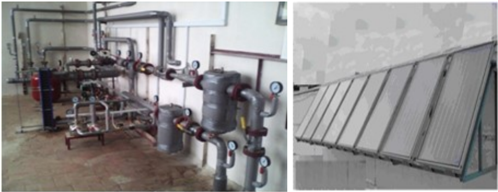
Рис. 7.12. Фото системи керування теплоспоживанням з комбінованим теплопостачанням і використанням сонячної енергії
