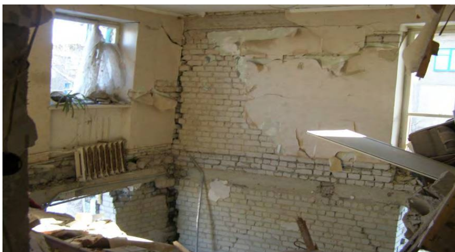
Рисунок 2. Обрушены перекрытия над вторым и третьим этажом. Трещины в углах здания шириной раскрытия до 150 мм. Разрушен защитный слой бетона и оголена арматура в междуэтажных монолитных поясах.
