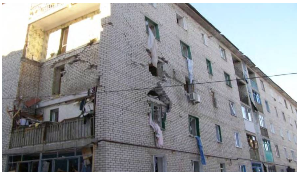
Рисунок 1. Деформирована и разрушена кладка наружной несущей стены блок секции жилого дома с образованием трещин с четвертого по второй этаж.
