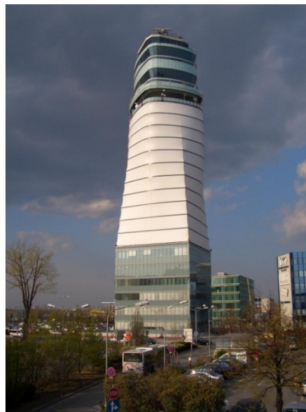
Рис. 5. Здание КДП, Vienna International Airport. Введено в эксплуатацию в 2004–2005 гг.
