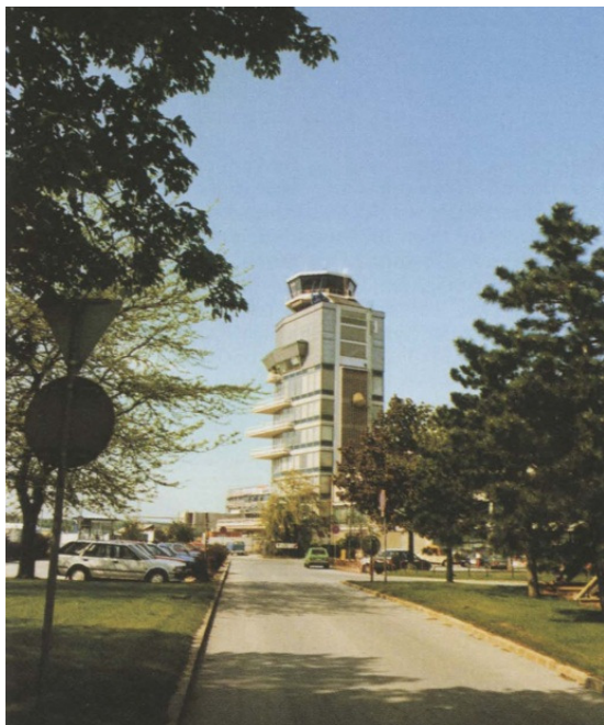
Рис. 4. Здание КДП, Vienna International Airport. Введено в эксплуатацию в 1960 г. (Wolfram 1988)
