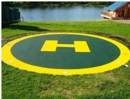
Рис. 4.8. Вертолітний майданчик із резиноним покриттям
