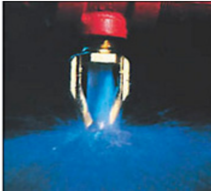
Рис. 3.8. Загальний вигляд спринклерного або дренчерного зрошувачів у дії
