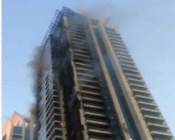
Рис.1.15. Пожежа 34-х поверхового житлового хмарочоса, м. Дубаї
