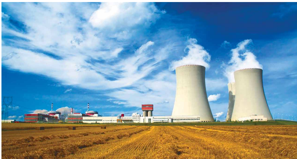
Мал. 31.3. Атомна електростанція на модульних реакторах
