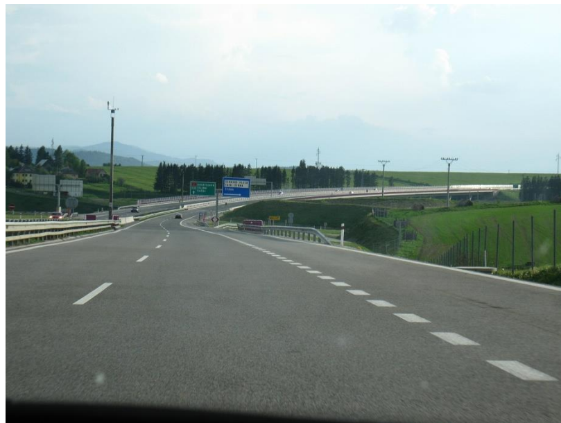
Рис. 2.6. Ділянка дороги E50 [65]
