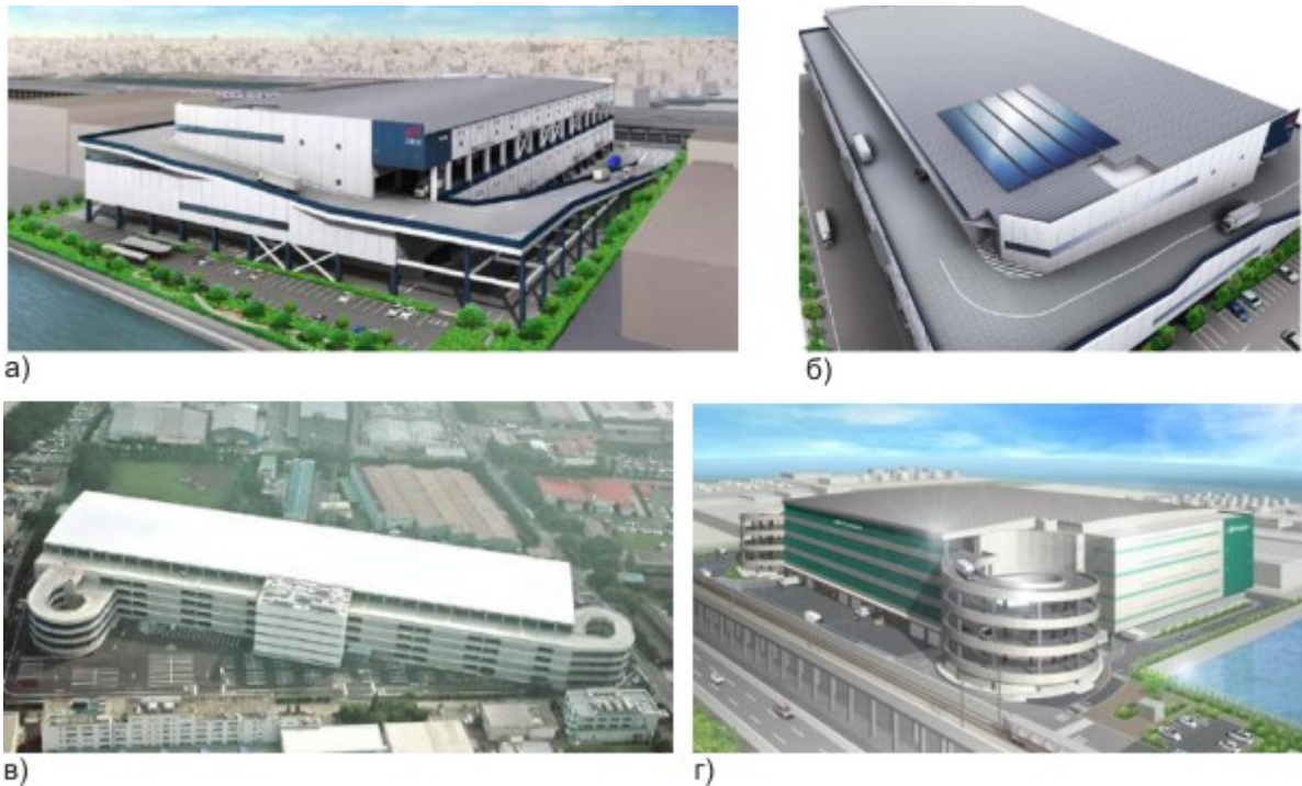
Рис. 1.5. Приклади багаторівневих складів: а,б) Chidori-cho Logistics Center, Ітікава (Японія), 2001.; в) Logi Port Kashiwa, Токіо (Японія); г) Ichikawa Logistics Center II, Ітікава (Японія), 2008
