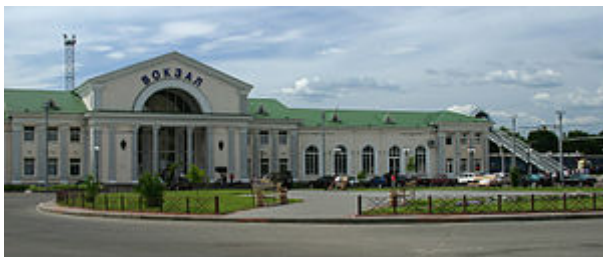
Рис. 1.25 Залізнична станція Полтава-Київська
