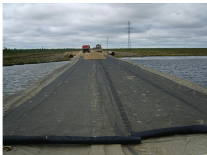
Рисунок 8 – Застосування базальтових сіток при будівництві доріг
