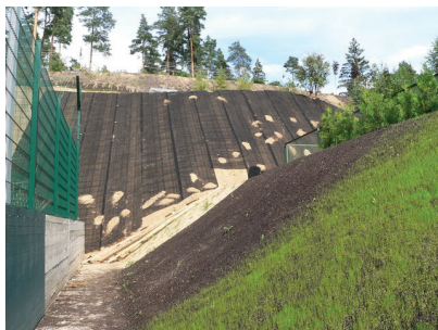
Рисунок 9 – Укріплення насипів дорожніми сітками
