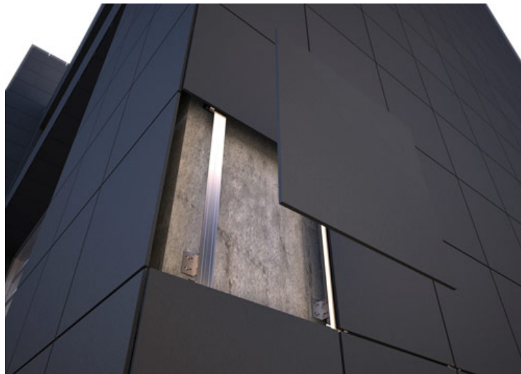
Рис. 1.40. Облицювання фасаду керамогранітом
