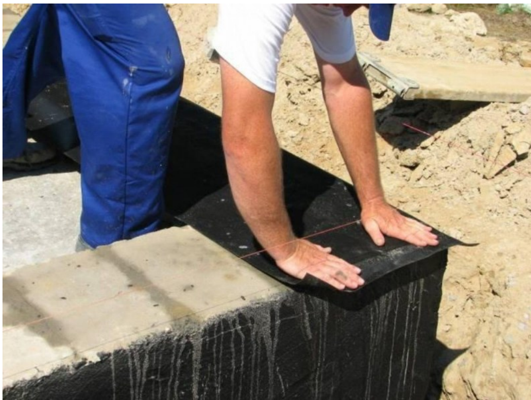
Рис. 2.3. Процес гідроізоляції
