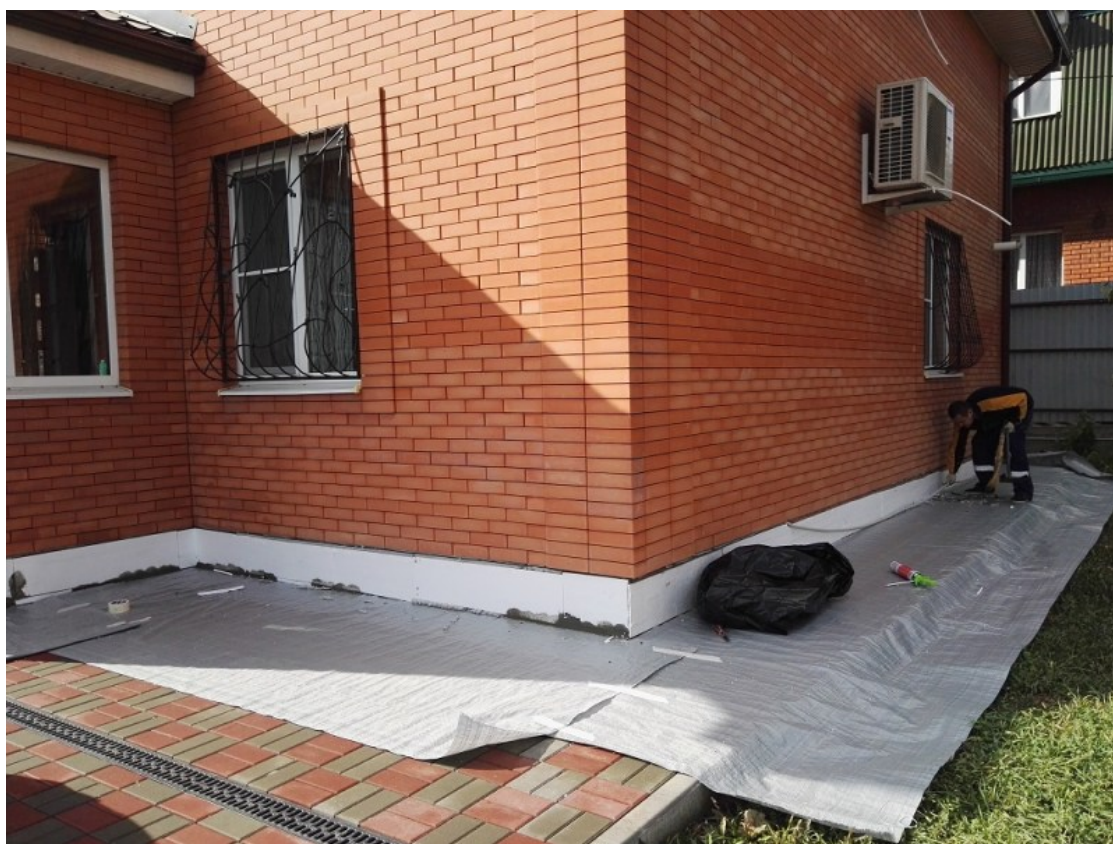
Рис. 2.4. Процес утеплення цоколю
