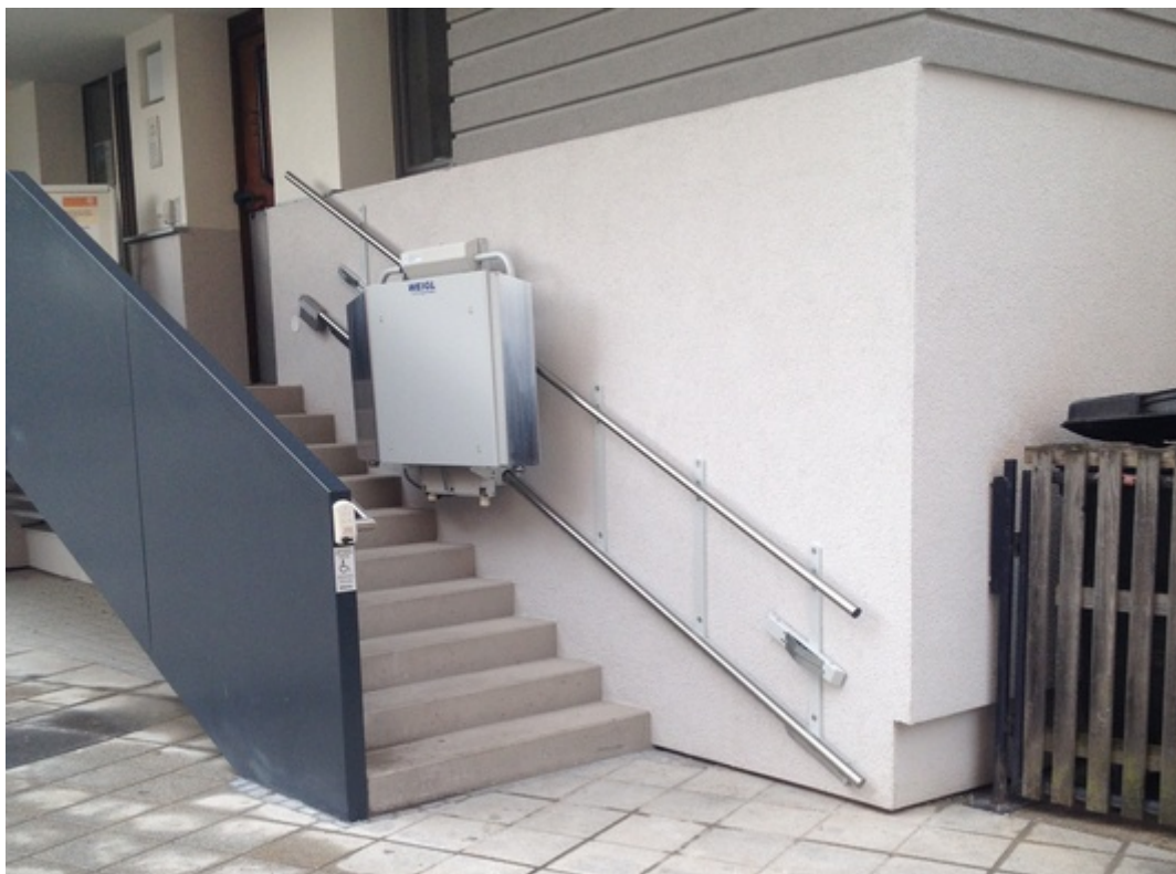
Рис. 2.15. Похилий підйомник для маломобільних груп населення
