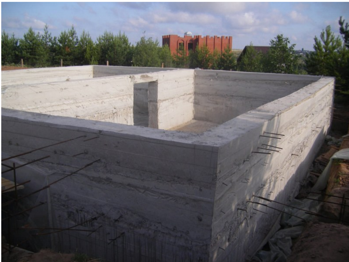
Рис. 2.2. Влаштування монолітногобетонного цоколю
