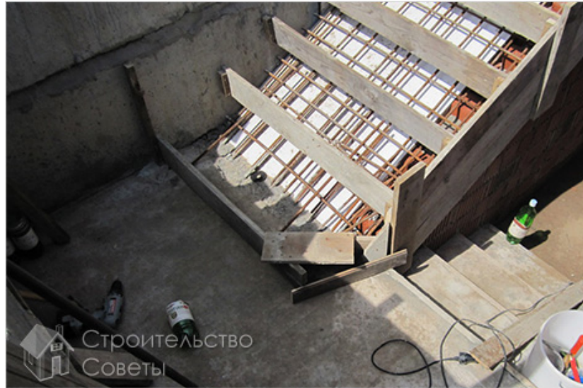
Рис. 2.13. Опалубка та армування до заливки бетоном
