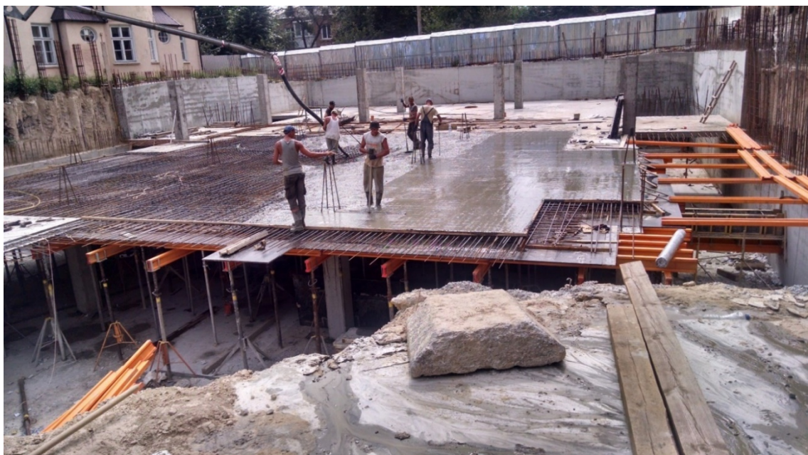
Рис. 2.10. Схема влаштування монолітного переkritтя
