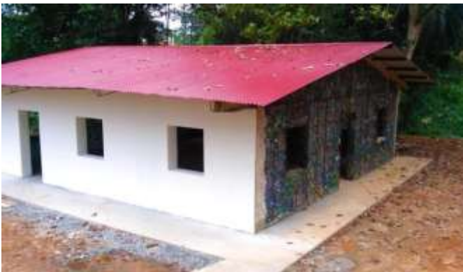
Рис.2 Фасад будівлі з пластикових пляшок
