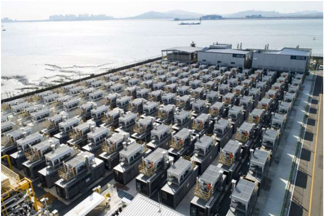
Рис. 1.16. Зовнішній вигляд станції з пташиного польоту.
