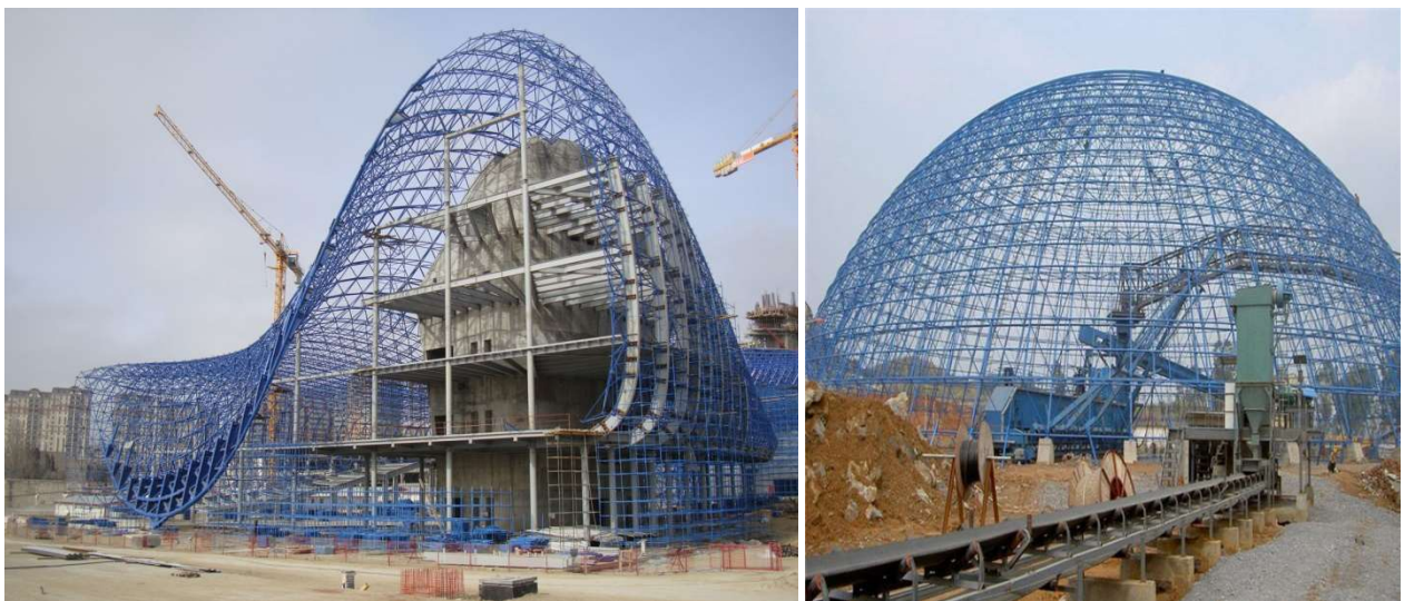
Рис. 5.1 Приклад використання структур в будівництві
