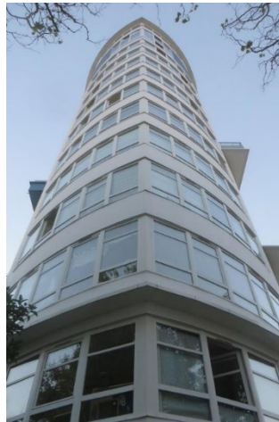
в) архітектурні деталі будівлі
