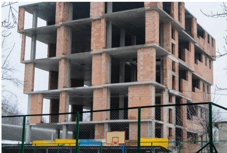
Рис. 5.4. Монолітно –каркасна технологія будівництва
