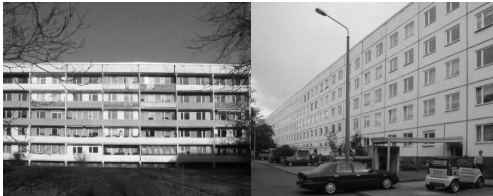
Будівля до реконструкції
