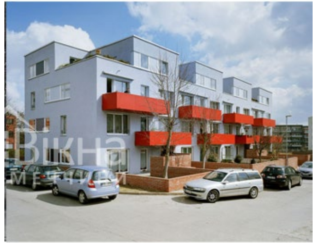
б) після реконструкції
