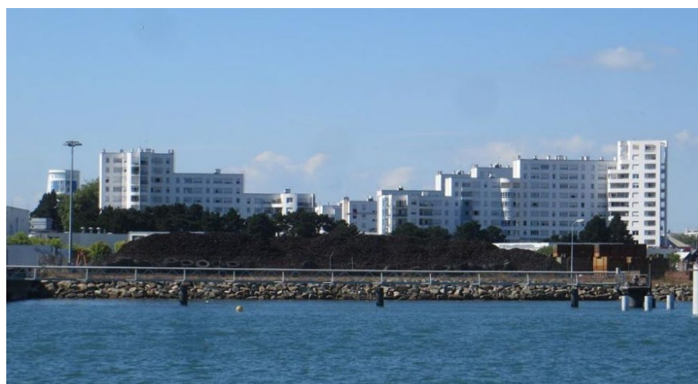
б) після реконструкції
