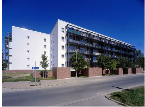
б) після реконструкції
