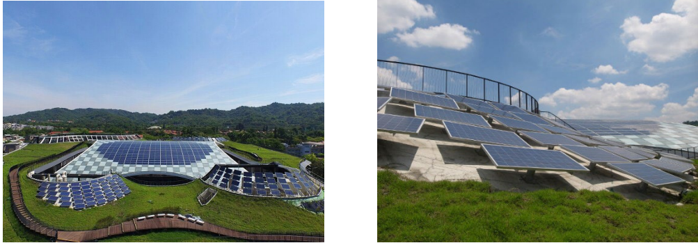
Рис. 3 Сонячні батареї на даху будівлі наукового центру
