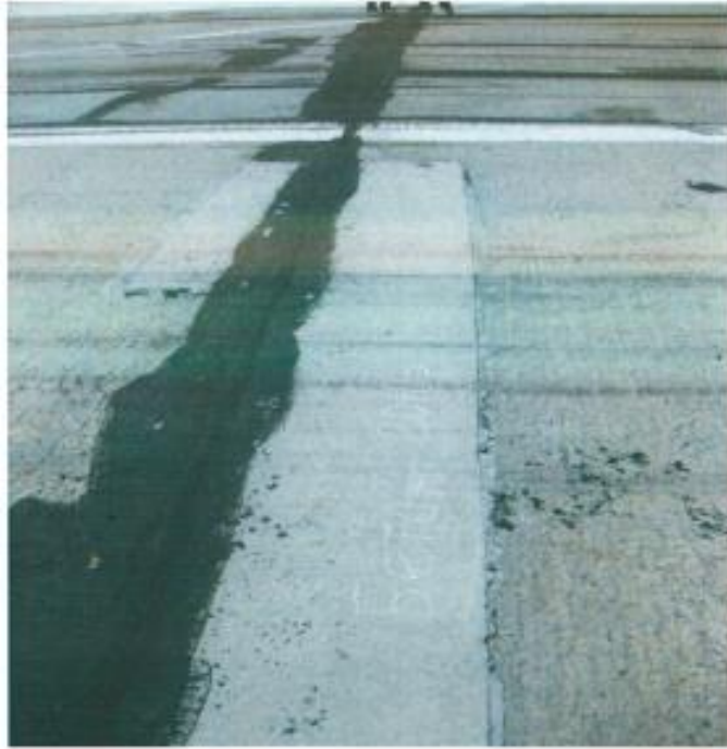
Рис. 4.2 – Поперечна тріщина ШЗПС
