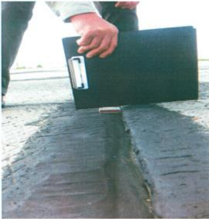
Рис. 4.10 – Розбіжність сусідніх плит у вертикальній площині
