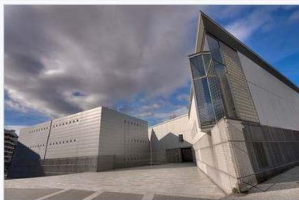
Будівля Генерального архіву Корони Арагону після 1993 року
