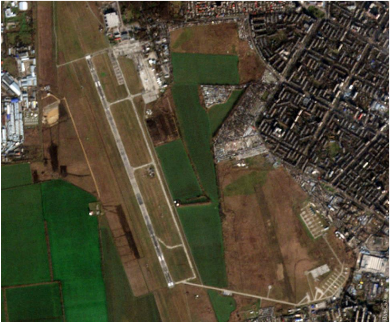
Рис 1.3. Вид аеропорту Одеса до реконструкції
