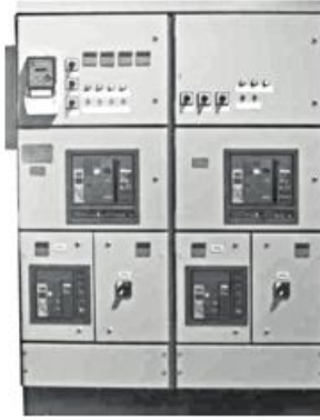
Рисунок 1.6 – Зовнішній вигляд РУНН КТП
