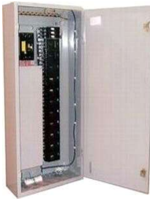
Рисунок 1.5 – Фото силового пункту ПР-11-3091
