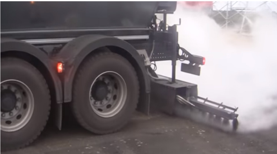
Рис. 5.5. Розливання в'язучої речовини автогудронатором
