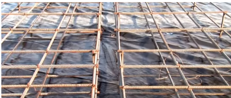
Рис.7.11. Конструкція арматурного каркасу при будівництві аеродромного покриття
