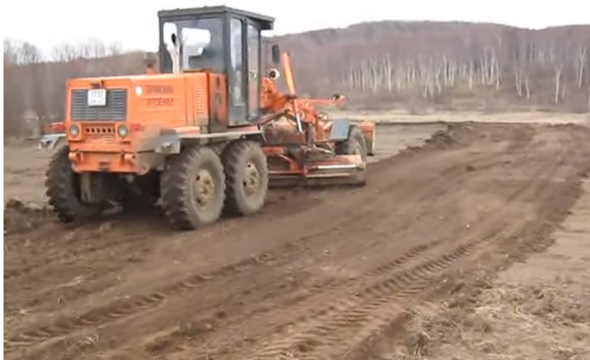
Рис. 4.2. Виконання планувальних робіт на аеродромі причіпним грейдером
