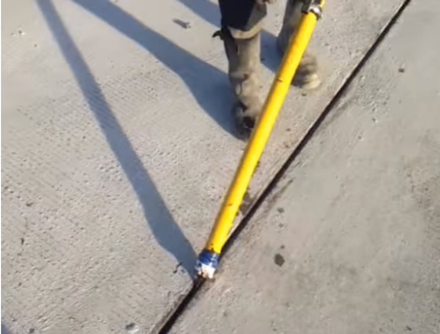
Рис. 7.15. Заповнення швів герметичним матеріалом в аеродромному покритті
