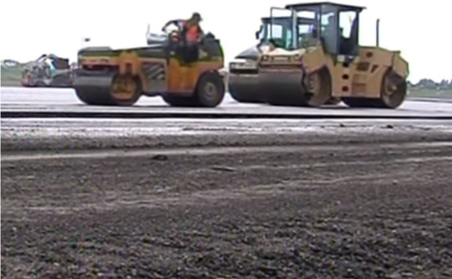
Рис. 12.3. Ущільнення асфальтобетонного покриття самохідними котками на пневматичних шинах та вальцевими котками
