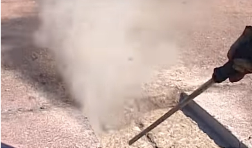
Рис. 12.1. Видалення слабого бетону з поверхні тріщини аеродромного покриття
