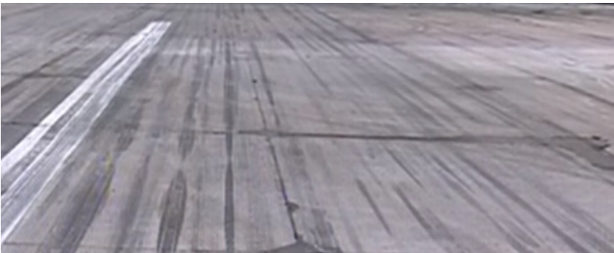
Рис. 12.2. Підготовлене старе цементобетонне аеродромне покриття перед нанесенням шарів асфальтобетону
