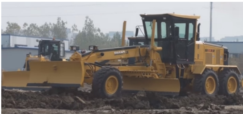
Рис. 4.1. Виконання планувальних робіт автогрейдером на аеродромі
