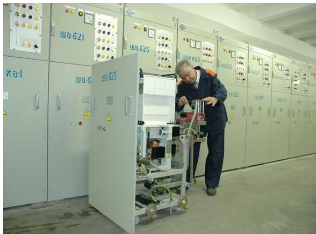
Рисунок 2.1 - Перевірка справності щитів вимикання
