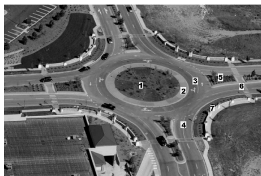
Рис. 2. Элементы планировки и обустройства современного кольцевого пересечения (Roundabout Design Standards, City of Colorado Springs 2005 г.): 1 – приподнятый центральный островок; 2 – априон ( apron, truck apron ); 3 – кольцевая проезжая часть; 4 – вход на кольцевое пересечение с стоп-линий (разметкой yield ); 5 – приподнятый разделительный островок ( splitter island ); 6 – пешеходный переход (в одном уровне с проезжей частью); 7 – ландшафтный буфер ( landscape buffer ), разделяющий пешеходный тротуар и кольцевую проезжую часть
