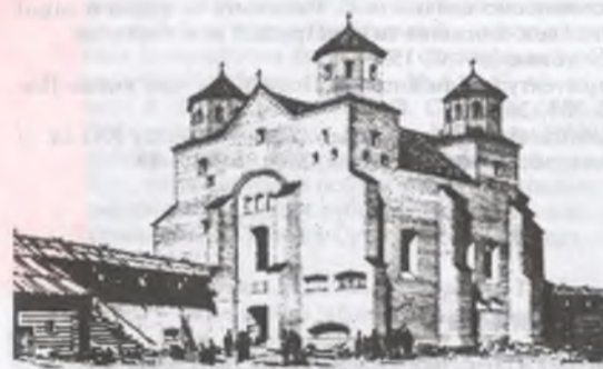
Святогірський монастир (1465–1495) в с. Зимно. Успенська церква. Перспектива. Реконструкція Г. Н. Логвина
