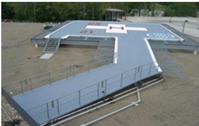
Рис. 2.22. Вертодром на рівні земної поверхні, виконаний з композитних матеріалів
