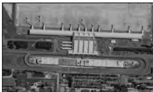
Рис. 3. Аеропорт «Бориспіль»: організація під'їзних шляхів до терміналу D (аерозйомка в перебігу будівництва багаторівневого паркінгу)
