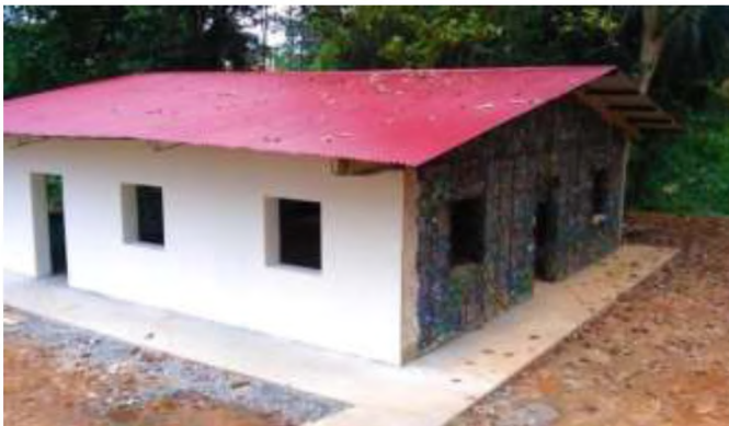
Рис.2 Фасад будівлі з пластикових пляшок
