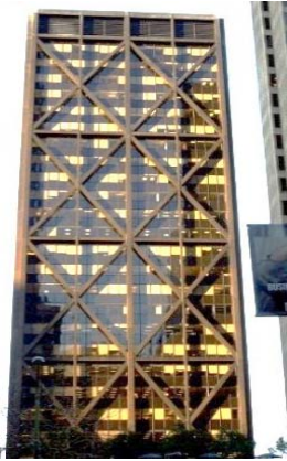
Рис. 6.13. Каркасні конструктивні схеми висотних споруд: а – напівжорстка (BMA Tower, м. Канзас-Сіті); б – жорстка (Nishi-Shimbashi Square, м. Токіо); в – з горизонтальними поясами жорсткості (Strarata SE1, м. Лондон); г – з зовнішньою розкісною оболонкою (One Maritime Plaza, м. Сан-Франциско); д – рамний каркас з оболонками (Hearst Tower, м. Нью-Йорк); е – трубна з зовнішніми аутригерами (HSBC Main Building, м. Гонконг)
