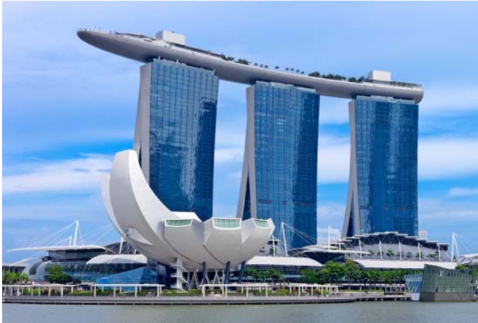
Рис. 5.26. Загальний вигляд багатофункціонального комплексу «Marina Bay Sands»
