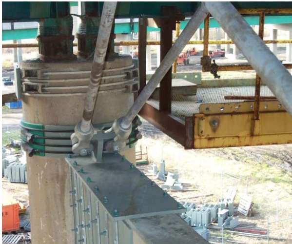
Рис. 6.8. Загальний вигляд опори «флет-джек»
