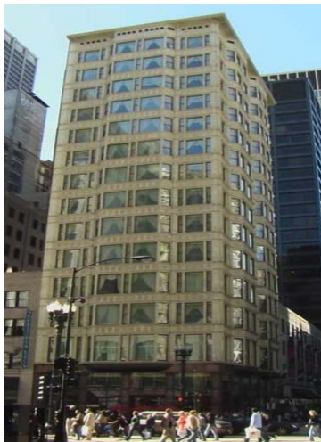
Рис. 4.11. Висотна конторська будівля Рілайнс-Білдінг
