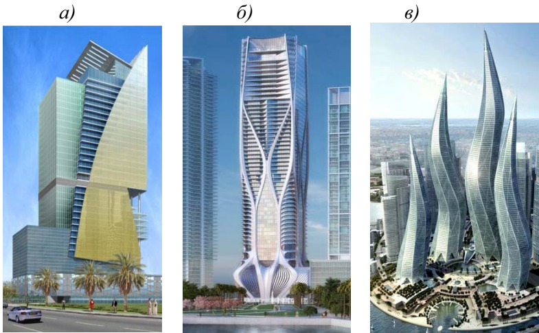
Рис. 5.5. Типи об'ємно-просторової композиції висотних будівель: а – вдосконалення простих геометричних форм; б – комбінація геометричних форм; в – створення біоформ
