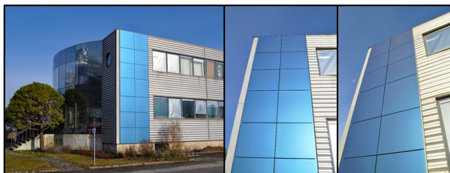
Рис. 33 Фотоелектричні облицьовувальні панелі на фасадах будівель
