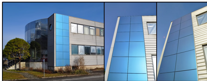
Рис. 5.2.2а. Зовнішній вигляд енергоефективної будівлі з фотоелектричних панелей
