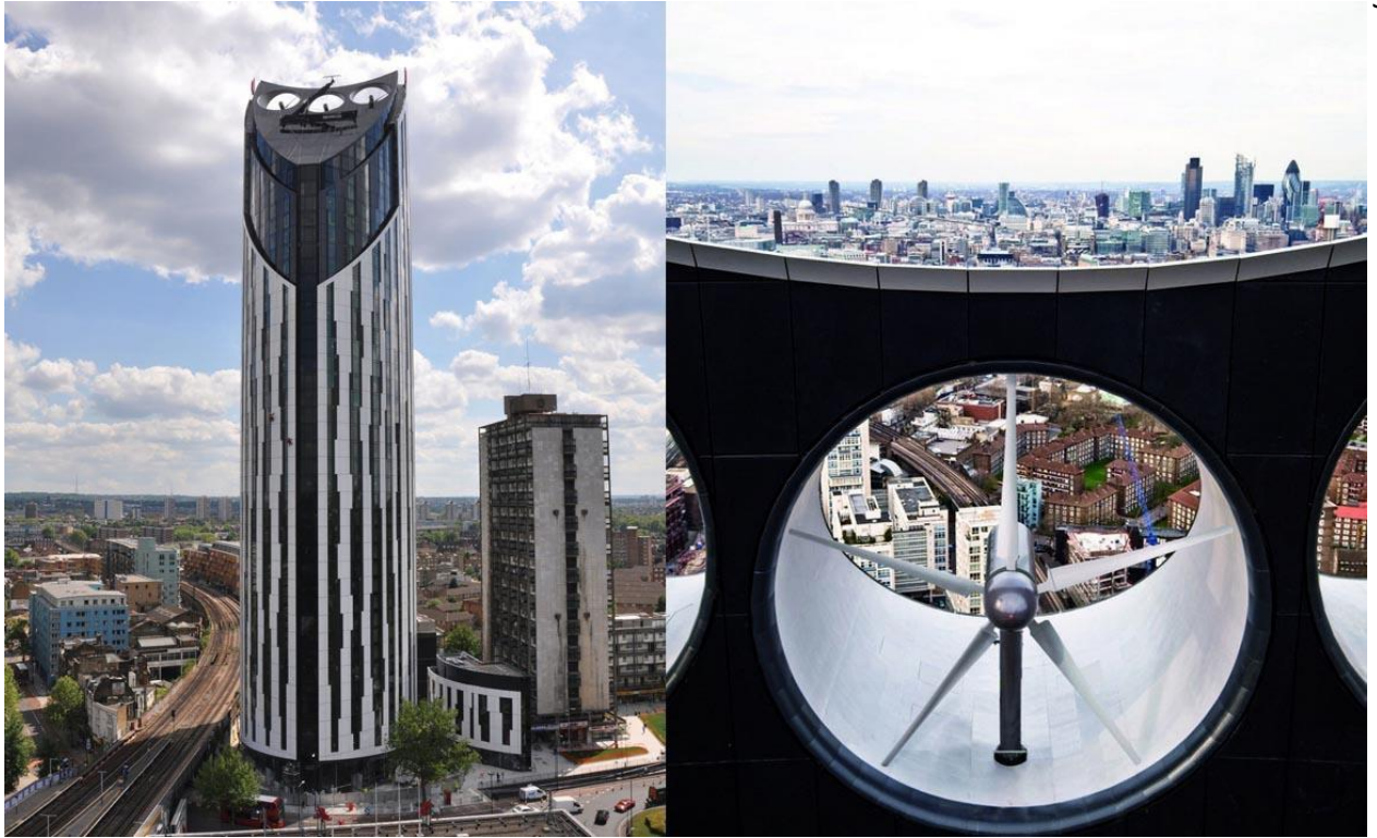
Рис.9. Загальний вигляд висотної будівлі "Вежа Страта". Отвір з енергогенератором у верхній частині об'єкта.
