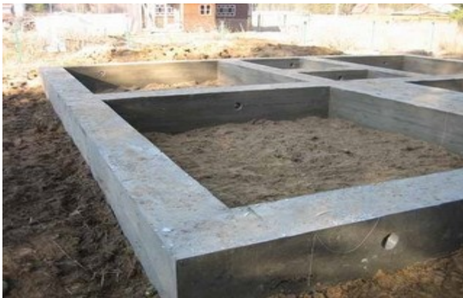
Рис. 5.3 Монолітний залізобетонний фундамент
