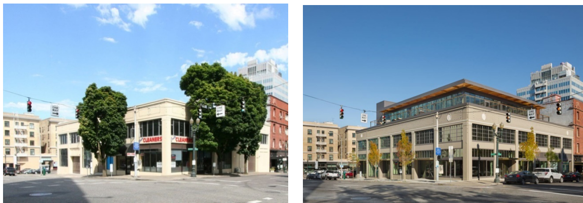
Рис. 1.31. Зовнішній вигляд гаража після реконструкції
