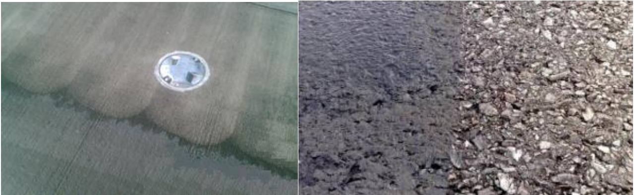
Мал. 3 Порівняння покриття ЗПС до і після очистки
