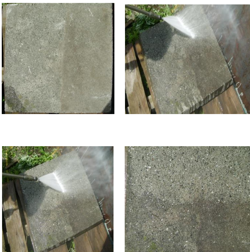
Мал.27. Поетапне очищення поверхні тротуарної плити від забруднення за допомогою гідроструменевого методу
