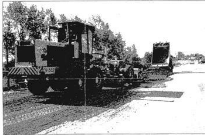
Рис. 3. Укладання шару бетонного прокату автогрейдером
