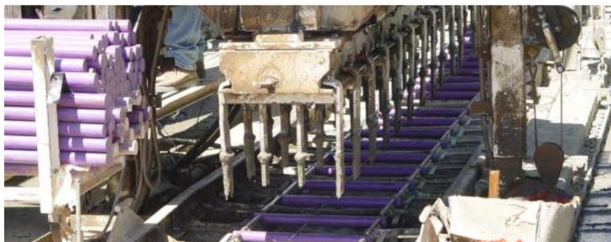
Рис. 5.3. Штирі швів стискання підготовлені до віброзанурення
