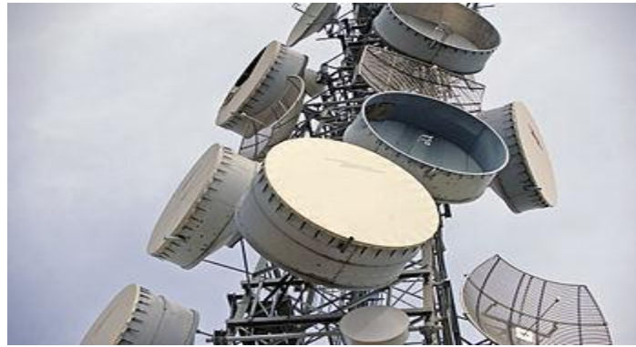
Рис. 1.17. Розміщення групи РРС на спеціальній вежі.
