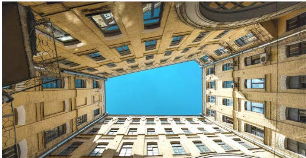
Рис.3.4. Сучасний стан фасаду з внутрішнього дворика
