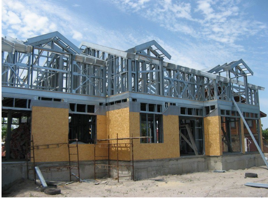
Рис.5.2. Структура металевого каркасу.
