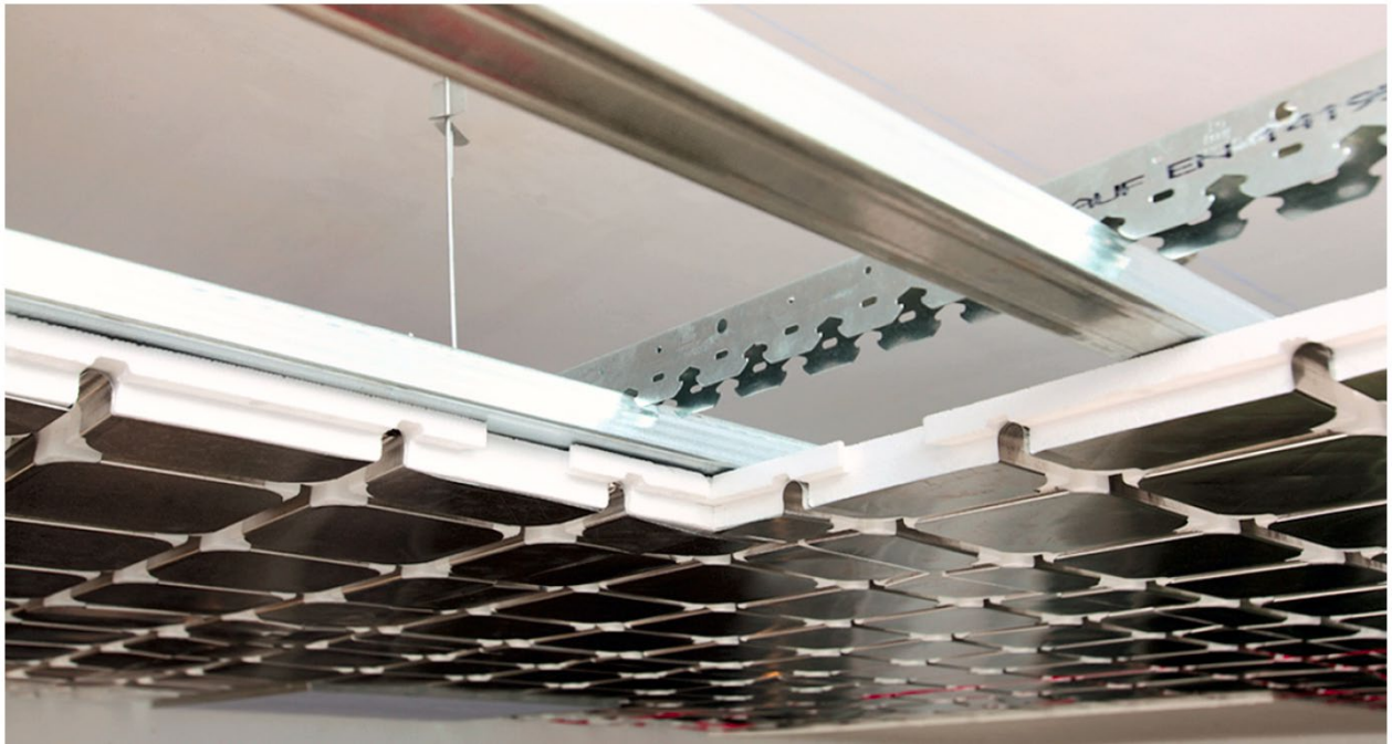
Рис.5.10. Внутрішня конструкція системи панельного опалення та охолодження.
