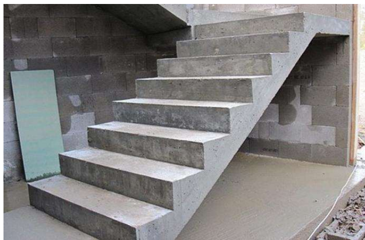
Рис. 5.13 Монолітні залізобетонні сходи на стадії будівництва
